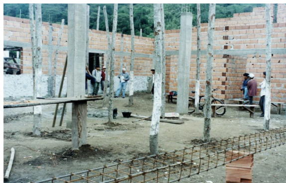
Imagen 12. Dentro del álbum-carpeta, bajo la carátula Inti Finca Santiago, Río Cortaderas. Registro de la construcción de un salón multiuso comunitario.
