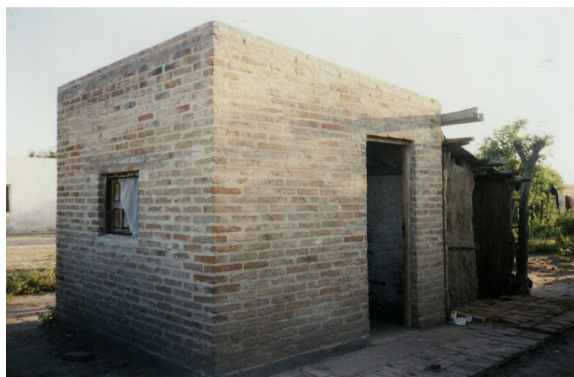
Imagen 10. Del álbum carpeta Chaco-Formosa-Ramal, bajo la carátula Chaco. "Refacción de 60 viviendas precarias. Barrios: Quinta 28, Quinta 17, Quinta 4 y Wichi". Tercera fotografía de la secuencia: Vivienda refaccionada.
